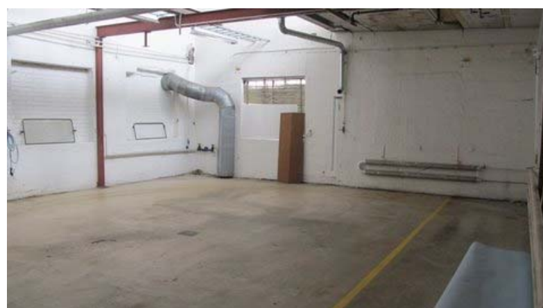
Gjuteriet västra rummet, 97+44 kvm mot NV
