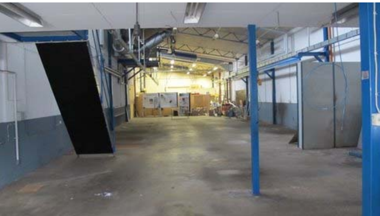
Verktygshallen från fönsterväggen under kontoret
