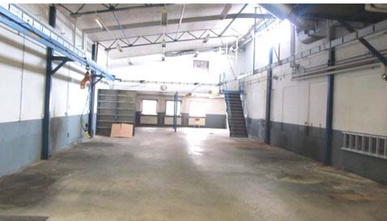
Verktygshallen mot fönsterväggen
